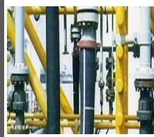
Нафтові рукави Таурус Емерги, Elaflex *с мідним дротом
